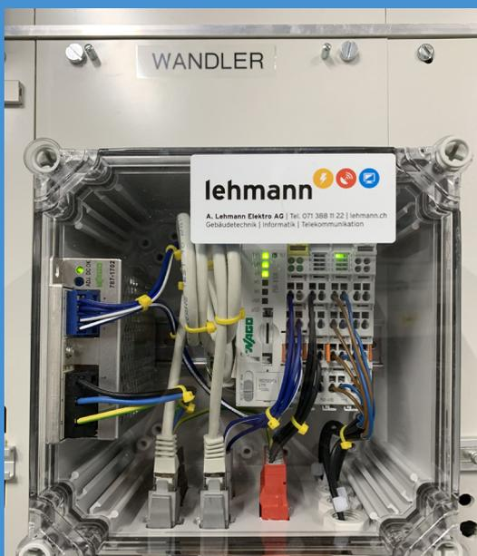
Die **Konfiguration** ist denkbar einfach und erfolgt über das integrierte Webportal. Darin lassen sich die angeschlossenen Ladestationen erfassen und die Parameter des Lastmanagement einstellen.
